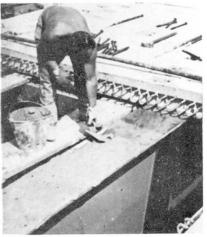
Photo n<sup>o</sup> 4 Couche de mortier pour les dalles
