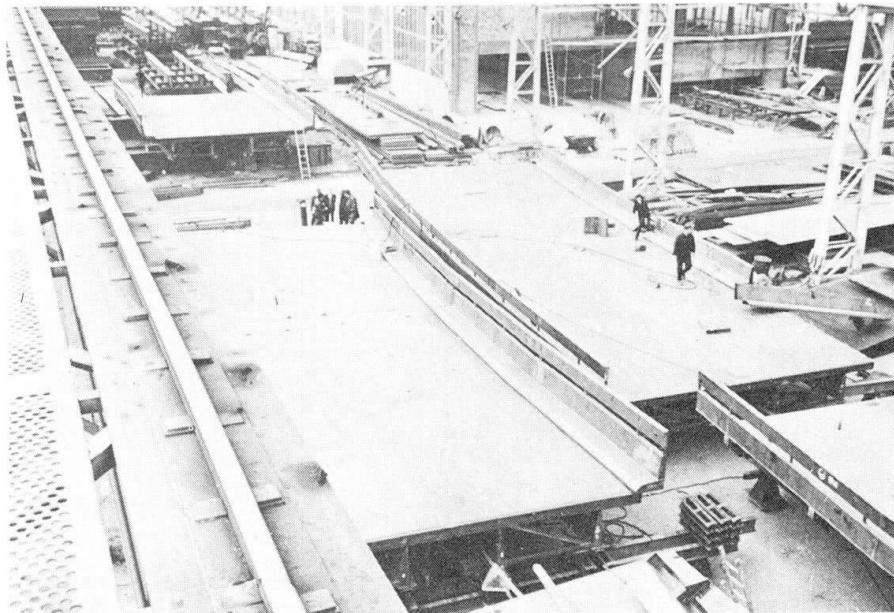
Bd.7 Probemontage in Werk der Firma Wiener Brückenbau
