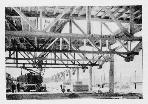
Bild 16 - Montage der Binderkonstruktion für einen Kompaktbau (Mobildrehkran).
