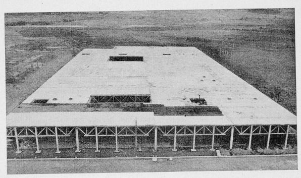
Bild 1 - Gesamtübersicht für ein Gebäude in Kompaktausführung, bei dem sich **alle** Produktionsanlagen unter einem Dach befinden.
