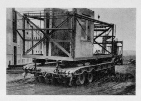
Bild 14 - Trägerfahrzeug (40 Mp Tragfähigkeit) mit rückwärts absetzbarer Rollpalette der Plattenbauweise.
