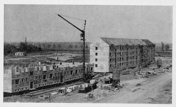
Bild 2 - Ubersicht zur Konstruktion und Montage von Wohngebäuden in Blockbauweise (750 kg max. Elementemasse), Montage mit Turmdrehkran 12 bis 16 Mpm Lastmoment.
