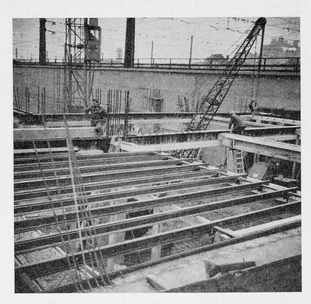
Fig. 2 - Gare d'Autobus de la Place Rogier à Bruxelles. Doubles cadres avec poutres Préflex de 16 m distants de 8,35 m. Les poutres secondaires sont préfabriquées en béton précontraint. Les nervures métalliques prennent appui sur les poutres secondaires et supportent les coffrages amovibles de la dalle coulée sur place.
