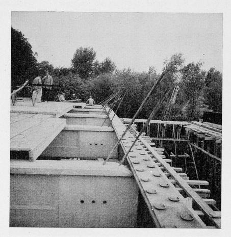
Fig. 3 - Nouveau Musée de l'Afrique Centrale à Tervueren. Poutres Préflex de 25 m de portée supportant les poutres secondaires en béton précontraint de 8,40 m distantes de 4,20 m. Le hourdis est composé d'éléments préfabriquées en béton précontraint. A noter, les barres de continuité des poutres secondaires qui sont repliées au-dessus des poutres Preflex.
