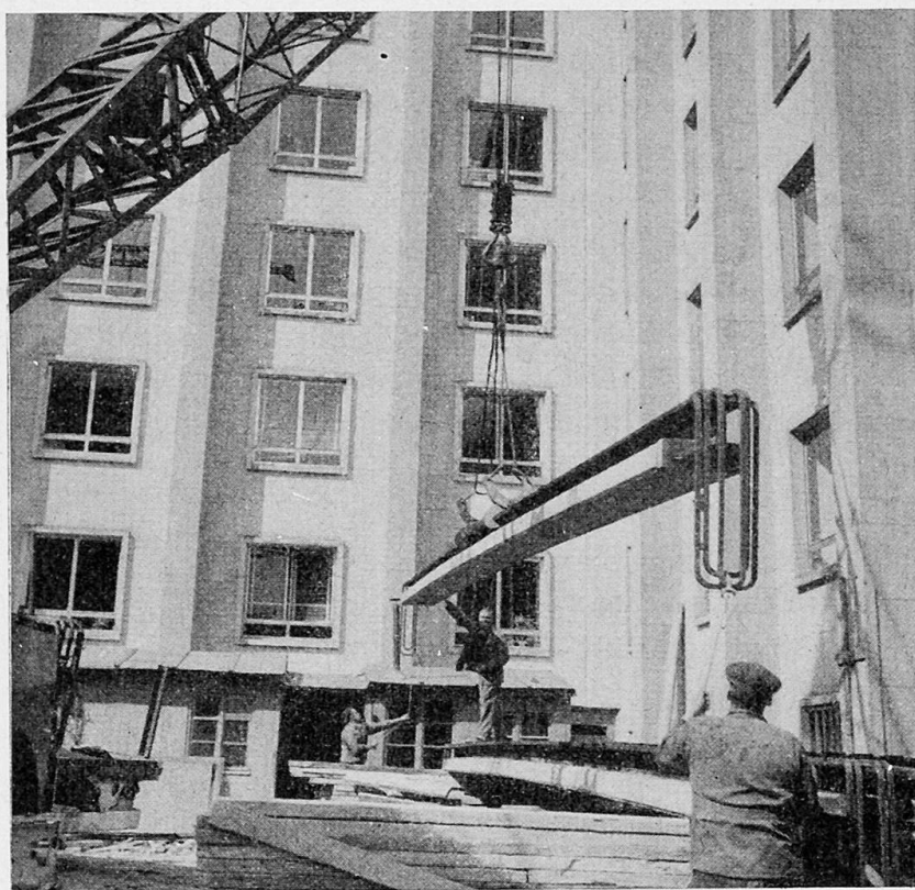
Fig. 4 - Complexe Administratif, rue de Louvain à Bruxelles . Poutres Préflex de 13,50 m avec aux extrémités des barres d'armature soudées à la poutrelle et servant à l'encastrement des poutres Préflex dans les colonnes.
