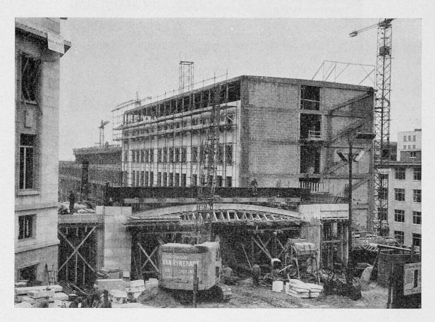
Fig. 5 - Complexe du Mont des Arts à Bruxelles. Une des deux poutres supportant le bâtiment qui surplombe la rue Montagne de la Cour. La voûte en pierres de France est suspendue à la poutre Préflex.
