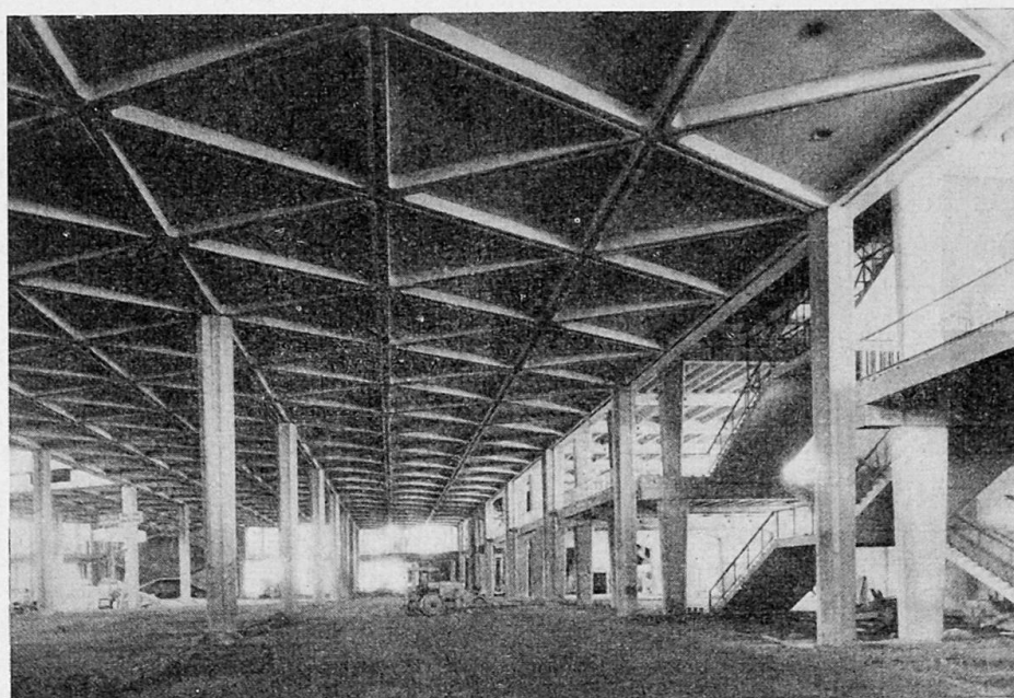
Fig. 22 et 23 - Palais du Centre National des Industries Techniques (CNIT au Rond Point de la Défense, Paris). Plancher central de 11.000 m 2 constitué de 1400 dalles triangulaires de 6 m de côté assemblées sur place par précontrainte en groupes de 9. Eléments préfabriqués à Nanterre et amenés par remorques routières (Balency, Boussiron, Coignet).
