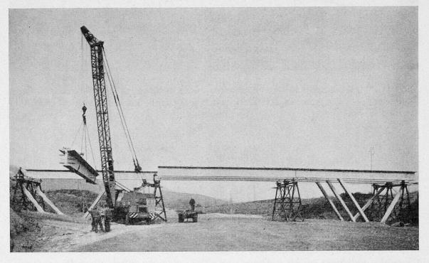
Abb. 9 - Als Überführungs-Bauwerke auf der Autobahn zwischen Genf und Lausanne sind 15 gleichartige, vorfabrizierte Brücken eingebaut worden. Ingenieur: Soutter und Schalcher, Zürich. Vorfabrikation: Igéco SA, Etoy.
