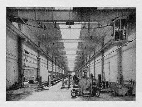
Abb. 3 - Spannbetonwerk in Avenches, mit ca. 80 m langen, permanent installierten Spannpisten. Ingenieur: M. R. Ros, Zürich. Unternehmer: Stahlton-Prébéton SA, Bern.
