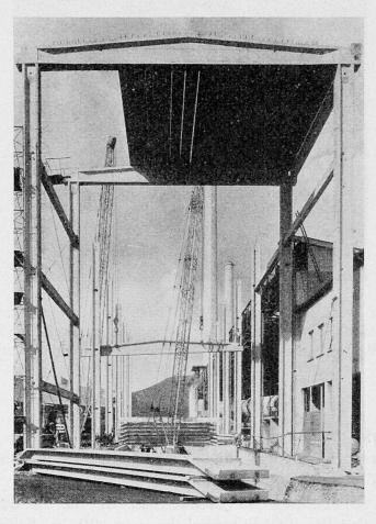
Abb. 6 - 20 m hohe Industriehalle aus vorfabrizierten BBR-I-Profilen und Balkenplatten in Wildegg. Ingenieur: E. Schubiger, Zürich. Vorfabrizierte Elemente: Stahlton AG, Zürich.
