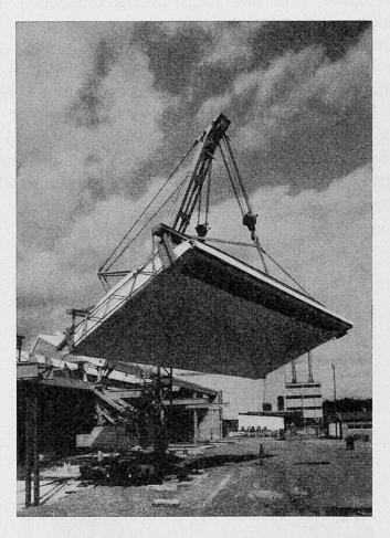
Abb. 7 - In einem Stück fabrizierte und im Spannbett vorgespannte Schalen-Segmente von 9 x 18 m werden von einem einzigen Pneukran angehoben (Baustelle Birrfeld, vergleiche auch Abb. 2). Ingenieur: Emch & Berger, Bern. Vorfabrikation: Element AG, Veltheim AG.
