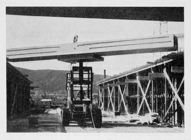
Abb. 4 - Montage von 18 to schweren Hohlplatten mit speziell angefertigtem Versetzgerät auf einer Baustelle in Herdern bei Zürich. Ingenieur: R. Henauer und J. Lee, Zürich. Unternehmer: Locher & Cie AG, Zürich.
