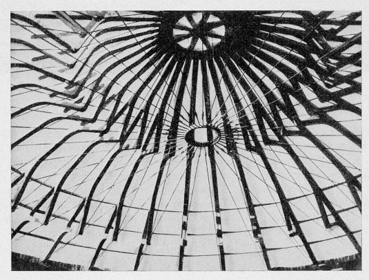
Fig. 1 - Couverture en éléments standardisés - Marché couvert de Zaragoza - Diamètre 22,50 m - Système MARSA.
