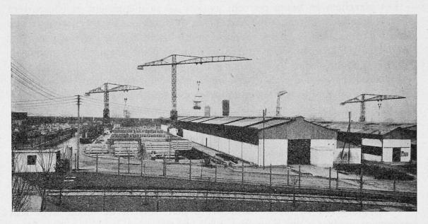
Fig. 5 - Usine de préfabrication à Villeneuve le Roi (1957) comportant des toits ouvrants et desservie par des grues (Balency).
