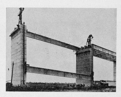
Fig. 31 - Pont de Tancarville: viaduc d'accès rive gauche, mise en place d'une poutre de 50 m par levage et ripage.
