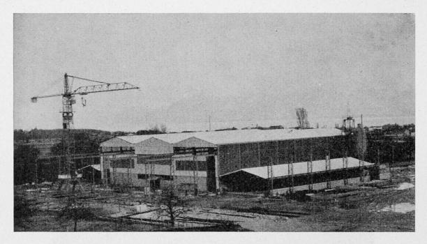
Fig. 6 - Usine de préfabrication à Genève (1962) essentiellement desservie par des ponts roulants (Balency).
