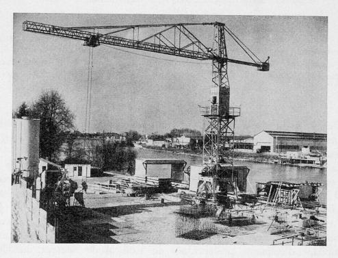
Fig. 27 - Pont de Choisy-le-Roi. Vue du chantier montrant les voussoirs préfabriqués côte à côte sur cintre correspondant à l'intrados du pont.
