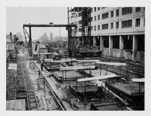
Fig. 2 - Préfabrication foraine desservie par portique et grue (Balency).
