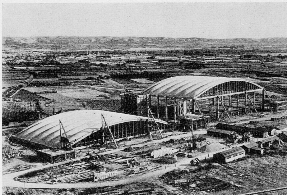
Fig. 29 - Hangar double de Marignane. Voûtes pesant 4200 t levées à 19 m.
