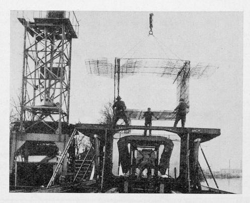
Fig. 26 - Pont de Choisy-le-Roi. Mise en place d'un ferraillage de voussoir préfabriqué (Campenon - Bernard).
