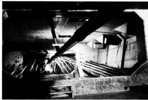
Fig. 24 - Viaduc de Poncin - Précontrainte extérieure
