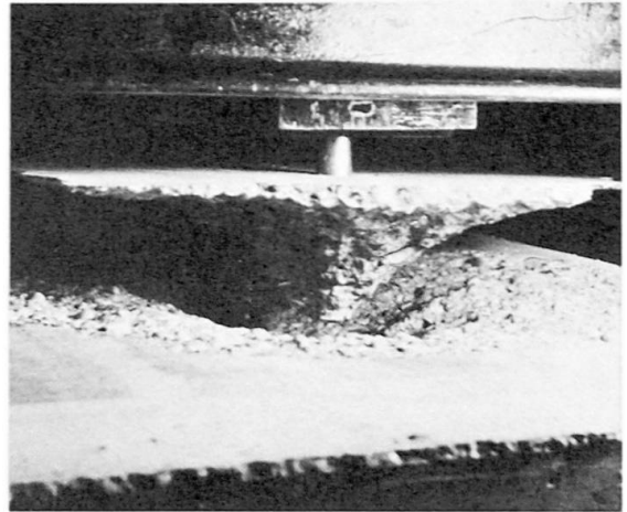
Bild 8 Bruchbild bei Betonausbruch
