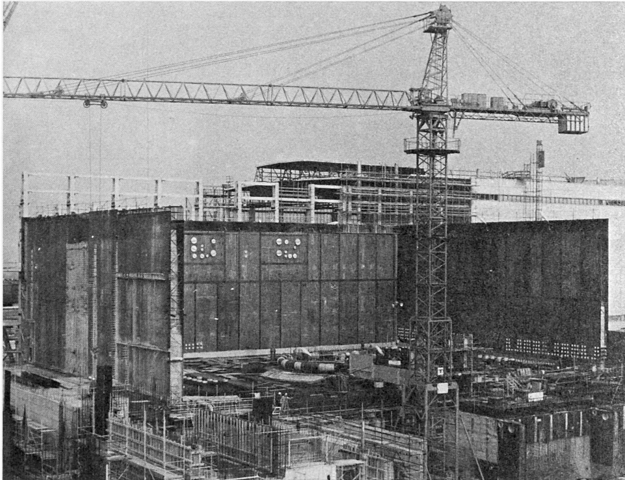
Bild 1 Montierte Wandzellen einer Reaktorbox
