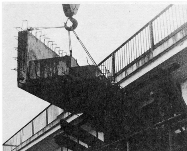
Fig. 22. Mise en place d'un des éléments préfabriqués en béton
