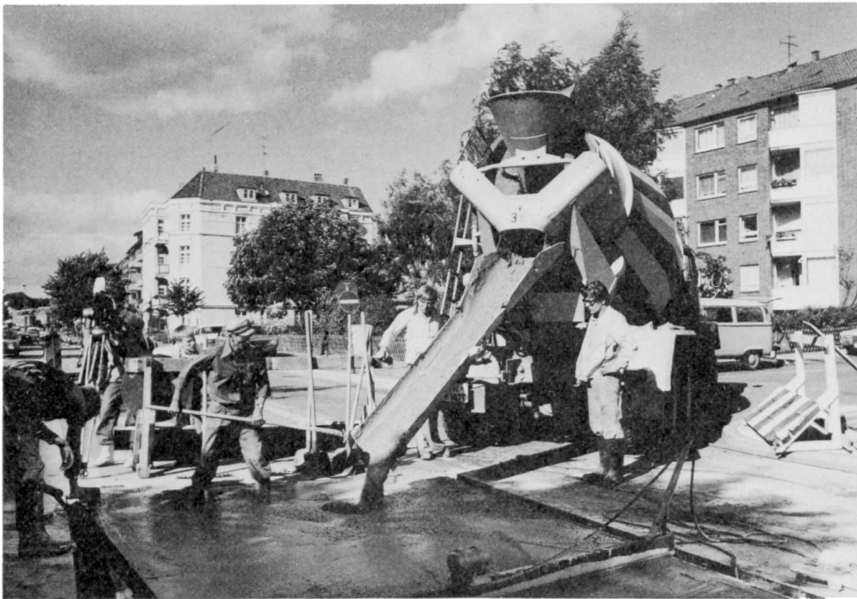
Bild 2: Fliessbeton im städtischen Strassenbau
