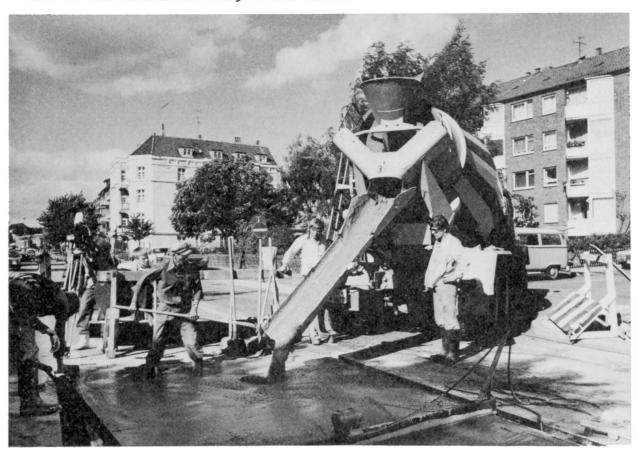
Bild 2: Fliessbeton im städtischen Strassenbau
