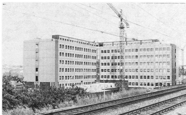
Fig. 4 Façades terminées des ailes ouest et sud
