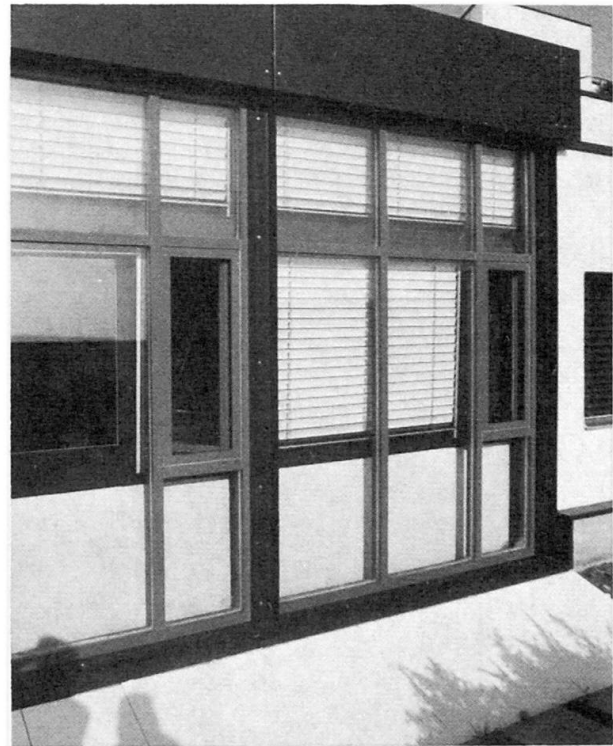
Die «Chamäleonfassade» auf Sonnengewinn/Sonnenreflexion eingestellt.
