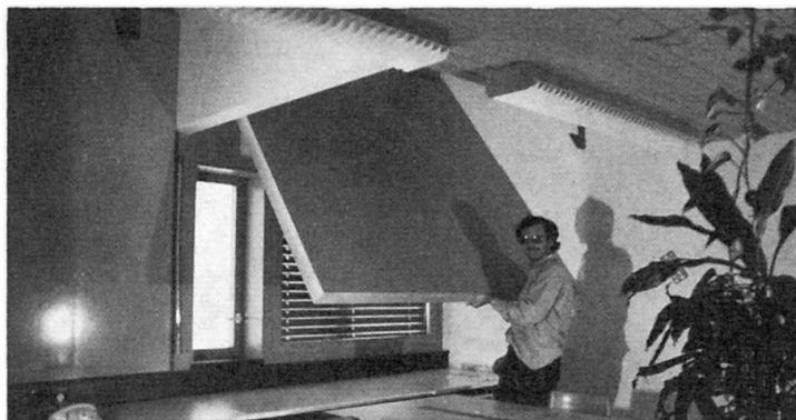
In der Nacht und am Wochenende werden Thermoläden von innen heruntergeklappt.
