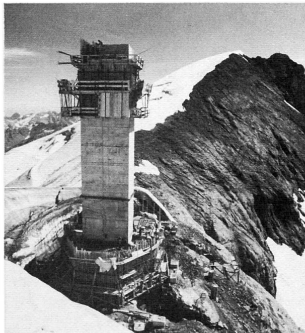
Bild 4: Rohbau August 1982: Liftturm mit Kletterschalung
