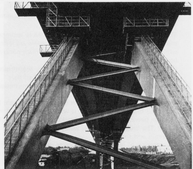
Fig. 2 Vue par dessous
