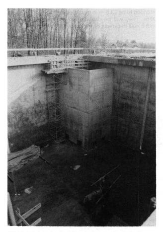
Bild 1 Blick in das Behälterinnere und auf die Spannwägen
