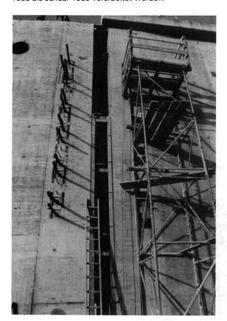
Bild 3 Verstzen von Injektionshauben in den schmalen Freiraum zwischen zwei Becken
