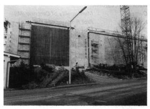
Bild 5 Die letzte Mittelwandscheibe in Ausführung, daran anschliessend bereits fertiggestellte Becken
