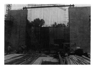
Bild 4 Die aufgehängten vertikalen Spannglieder einer mittleren Wandscheibe
