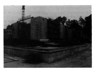
Bild 2 Im Vordergrund ist die als erste hergestellte Beckensohle zu ersehen; im Hintergrund bereits fertige Wanddecken mit noch fertigzustellenden mittleren Wandscheiben
