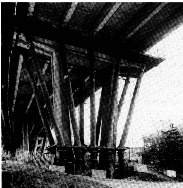
Fig. 1 Montage des palées au droit d'une pile
