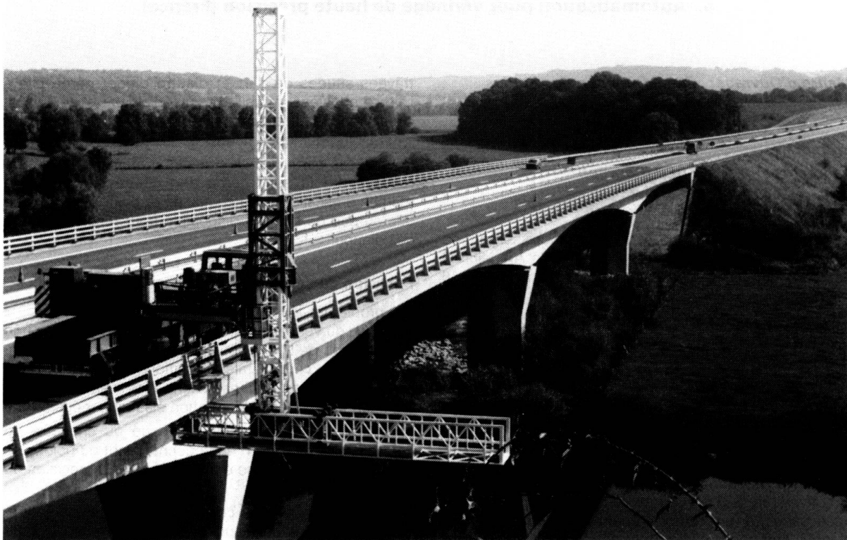
Fig. 2 Système «SCORPION» pour la radioscopie d'un pont à caisson
