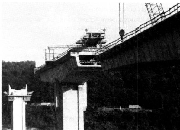
Fléaux en cours de pose
