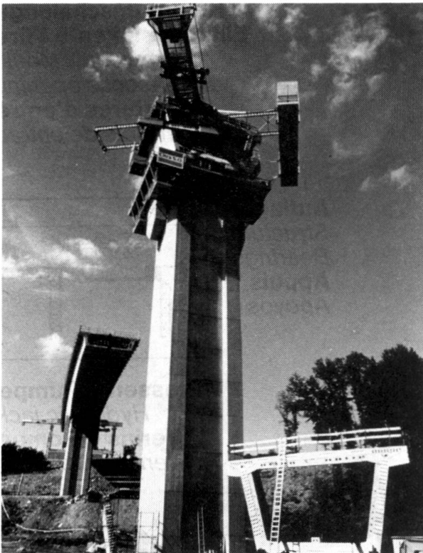
Mise en place du voussoir sur pile
