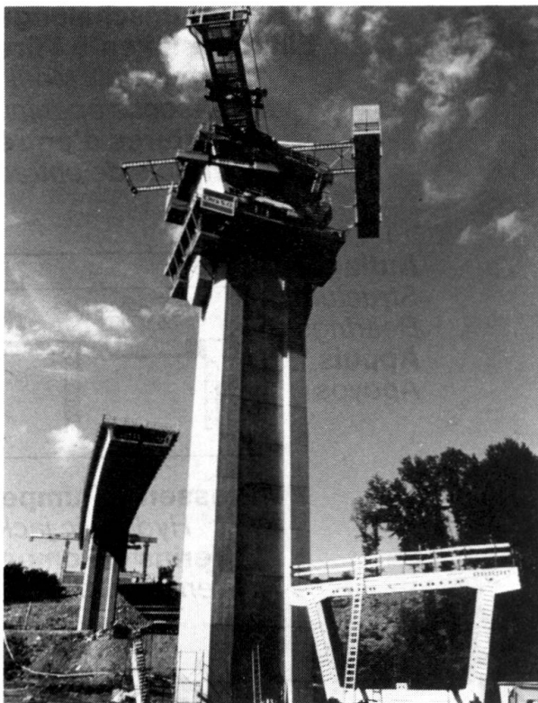
Mise en place du voussoir sur pile
