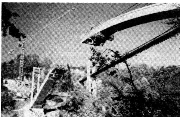
Fig. 4 Construction de l'arc
