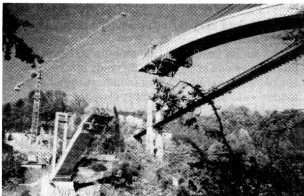
Fig. 4 Construction de l'arc
