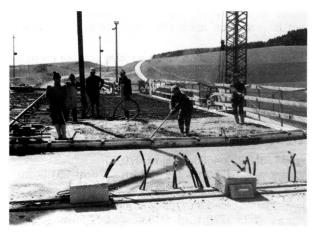
Bild 3 Die Vakuumbehandlung des Betons mit Tremix Vakuumausrüstung
