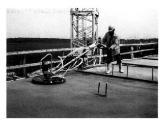
Bild 4 Das Abscheiben der Betonoberfläche mit Tremix Rotorplanglätter
