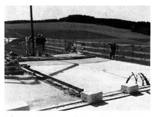
Bild 2 Das Abziehen des Betons mit Tremix Flächenfertiger
