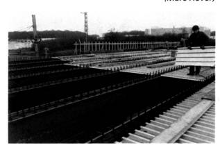
Mise en place du coffrage métallique permanent
