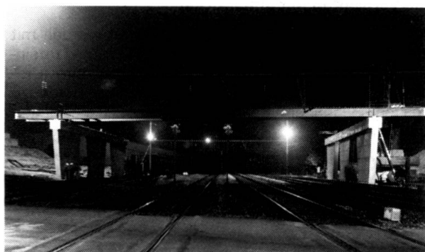
Pose des poutrelles longues de 43 m
