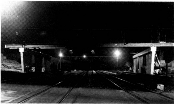
Pose des poutrelles longues de 43 m
