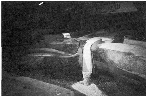
L'ouvrage est précontraint transversalement et longitudinalement (36 câbles 19 T 15) pour assurer l'étanchéité de l'ouvrage sans avoir recours à une chape qui s'userait intensivement au passage des laves.
