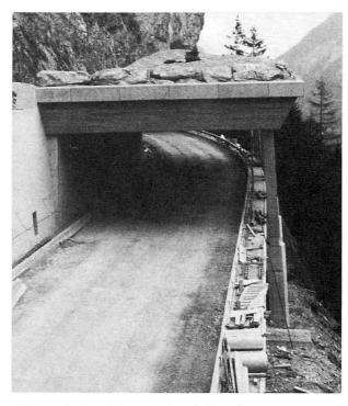
Bild 3 Steinschlaggalerie mit V-Stützen
