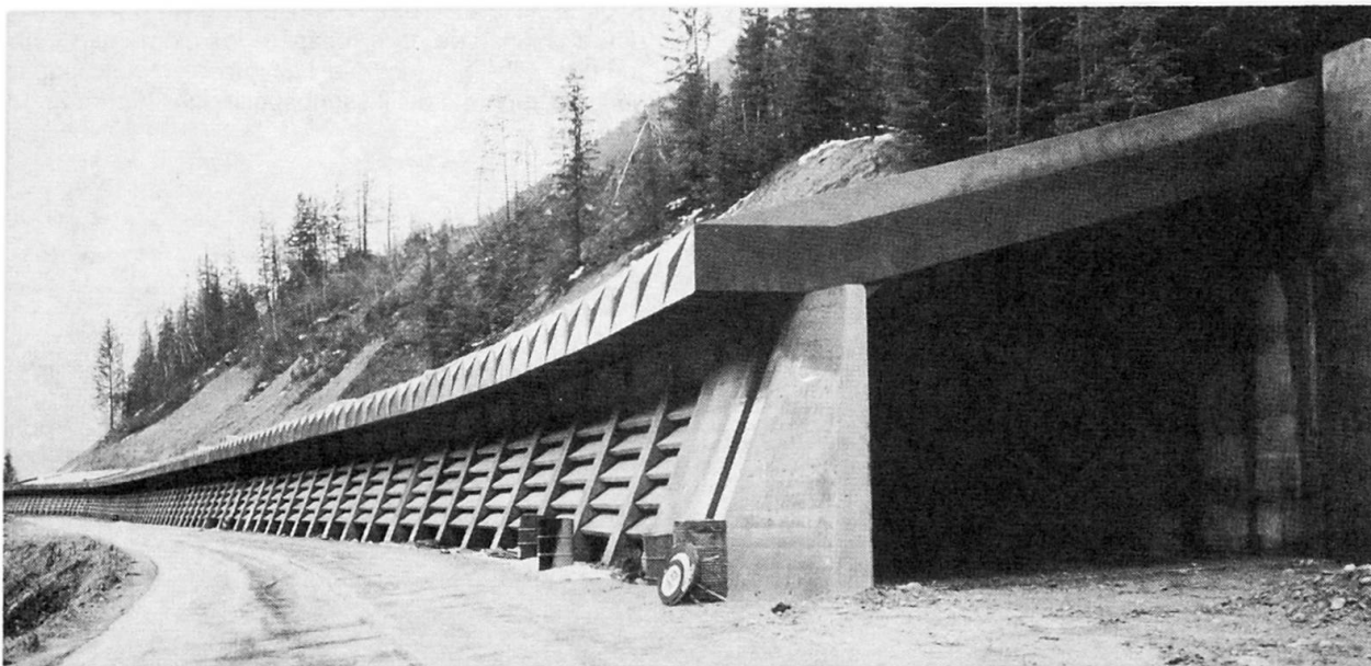
Vue de l'ouvrage paravalanche
