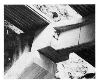
Abb. 3 Detail Trägerauflager mit Zugverankerung
