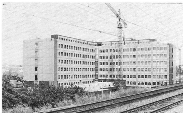
Fig. 4 Façades terminées des ailes ouest et sud
