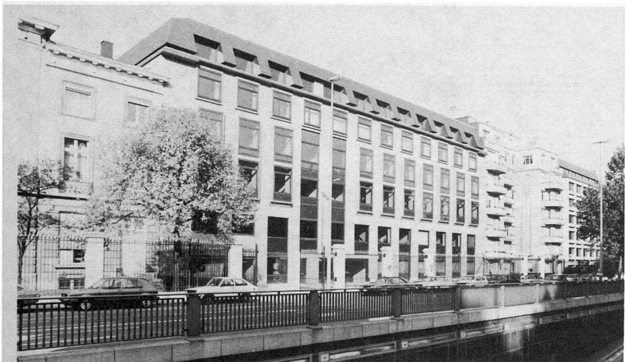
Vue du centre administratif
