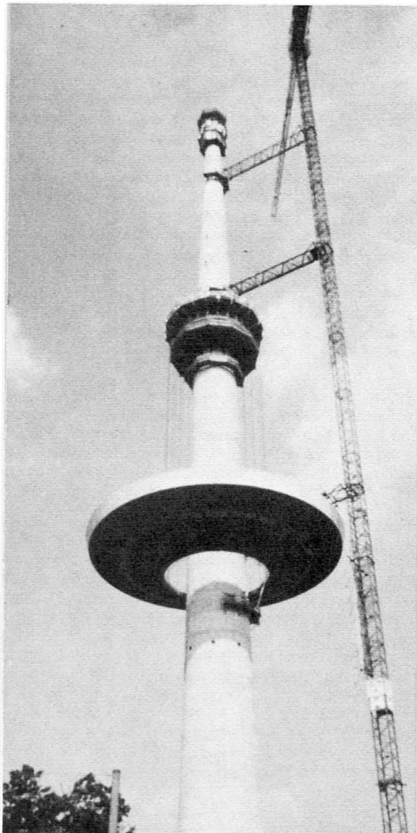
Bild 2 Hochziehen der 1200 Tonnen schweren Kegelschale
