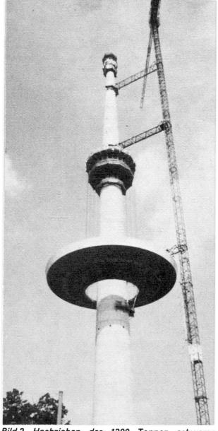
Bild 2 Hochziehen der 1200 Tonnen schweren Kegelschale
