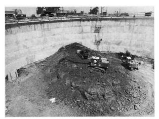
Bild 2: Aushub- und Betonierarbeiten in etwa 12 m Tiefe
