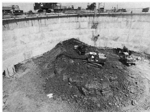
Bild 2: Aushub- und Betonierarbeiten in etwa 12 m Tiefe
