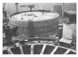
Bild 6 Der letzte Schritt war das Betonieren der Zwickel zwischen den Radialbalken und der oberen durchgehenden Betonschicht vom Zentralbereich her. Aus dem Speichenrad mit untenliegender Platte entstand schliesslich, wie im hinteren Teil der Abbildung zu erkennen ist, eine Kreisplatte.
