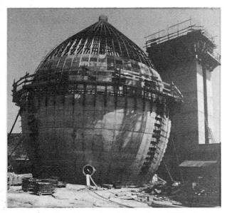
Untere Hälfte betoniert, obere Hälfte in Aus-Bild 3: führung
