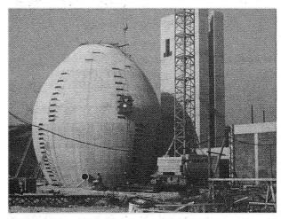
Bild 1: Der erste der beiden Faulbehälter im Bauzustand
