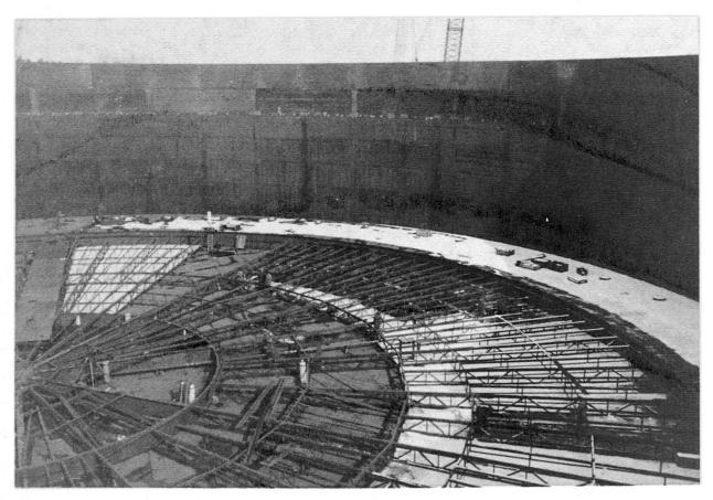
Doppeldeck-Schwimmdachtanks à 130000 m³, Durchmesser 80m
