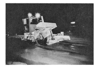
Fig. 1 Sciage de la piste existante en éléments de 7×12 m, profondeur de coupe maximum 50 cm
