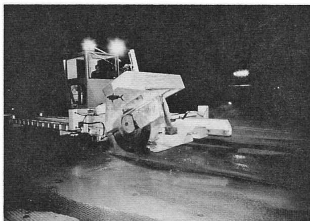
Fig. 1 Sciage de la piste existante en éléments de 7 \times 12 m, profondeur de coupe maximum 50 cm
