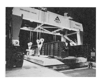
Fig. 4 Transport et mise en place des dalles préfabriquées
