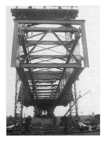
Bild 2 Stahlkonzeption für den Hauptträger
