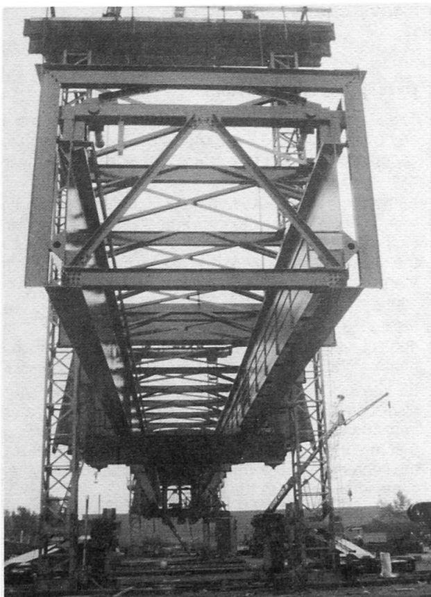
Bild 2 Stahlkonzeption für den Hauptträger
