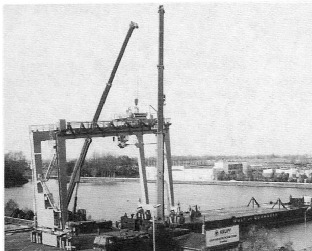
Montage des dritten Container-Stapelkrans, den Krupp Industrietechnik, Werk Wilhelmshaven, für den Hamburger Hafen geliefert hat (Foto Krupp)
