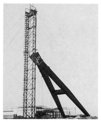
Bild 2 Beinstütze in Hebephase
