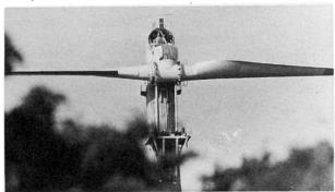
Bild 3 Hub der 75 m Ø Rotorblätter
