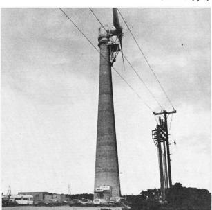
Bild 4 Die Turbinenachse liegt 80 m über dem Boden
