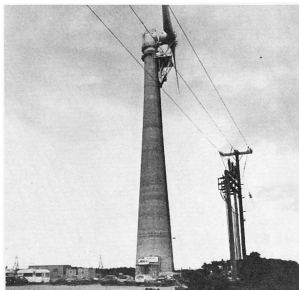
Bild 4 Die Turbinenachse liegt 80 m über dem Boden
