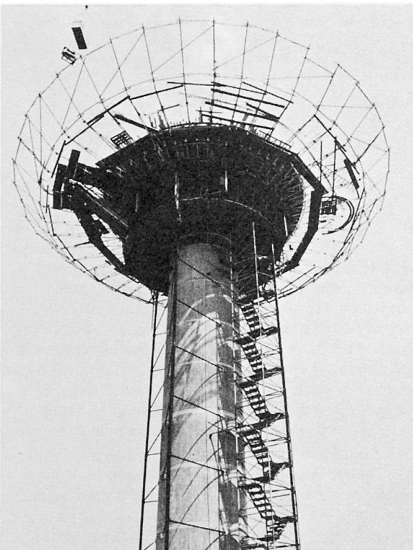
Bild 2 Erste Etappe des Kelches geschalt und betoniert Beginn der Kelch-Restmontage
