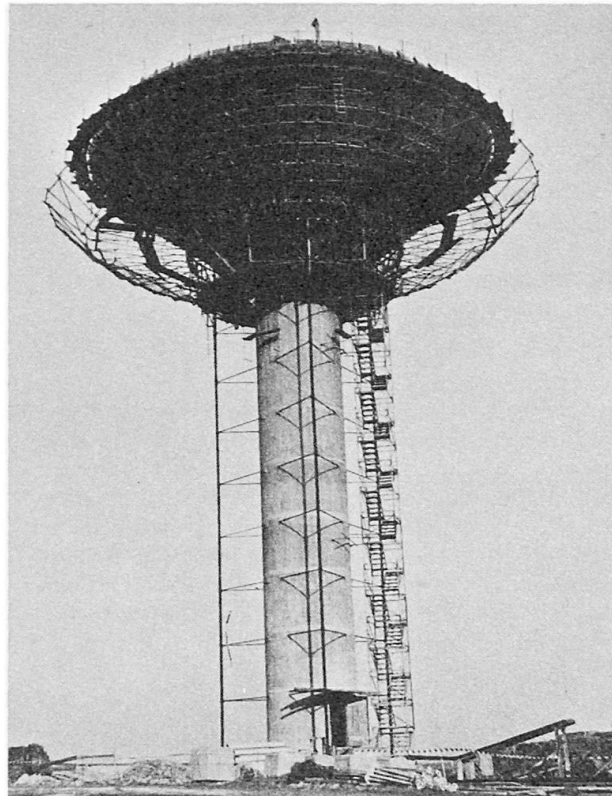
Bild 3 Fertiggeschalter Wasserturm, bereits am Betonieren Montage und Sicherheitsgerüst entlastet
