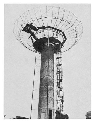
Bild 1 Schaft fertiggestellt Montage und Sicherheitsgerüst in Position gebracht
