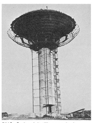
Bild 3 Fertiggeschalter Wasserturm, bereits am Betonieren Montage und Sicherheitsgerüst entlastet
