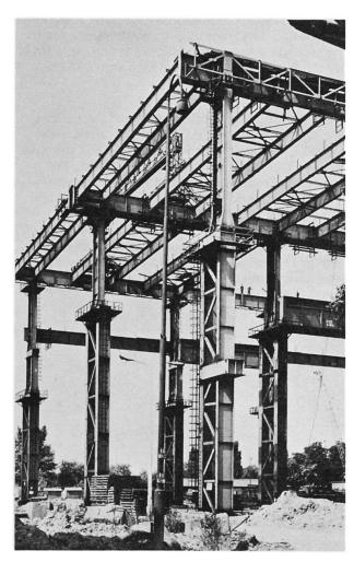
Im Feld zwischen den Stützenreihen a-B besteht die Konstruktion aus einem räumlichen Rahmentragwerk, mit Baustellen-Schweissstössen, in beiden Richtungen durch Längsverbindungen versteift. Oberhalb der Stützenreihen A/B und B, zwischen den Stützen 4 und 7, in einer Höhe von 25 m, befinden sich 10 m hohe Fachwerkträger von 24 m Spannweite. Das Gewicht der grössten Elemente war 130 t. Die Zusammenstellung und Einhebung erfolgte wie bei den Stützen und Kranbahnen.
