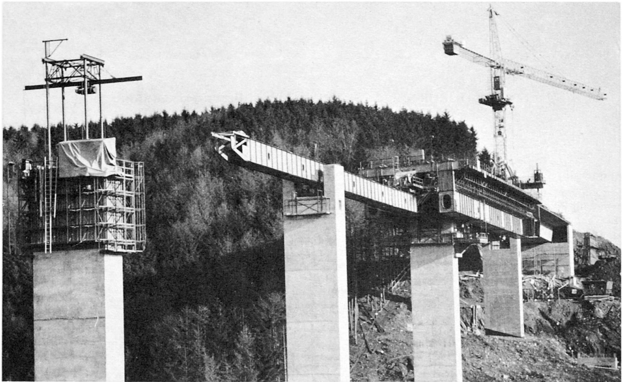
Bild 2 „Rechenschieber“; im Vordergrund selbstkletternde Pfeilerschalung
