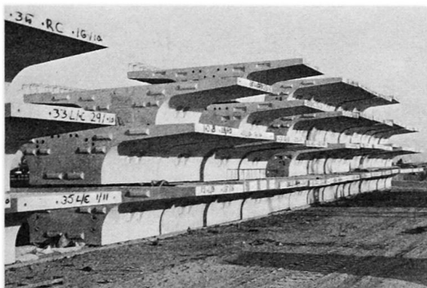
Fig. 2 Aire de stockage des voussoirs
