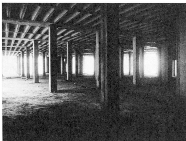
Bild 2 Konstruktion des Rohbaus
