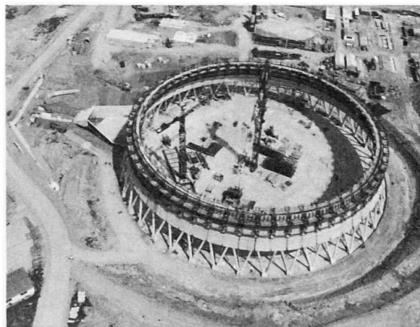
Coque en cours de construction
