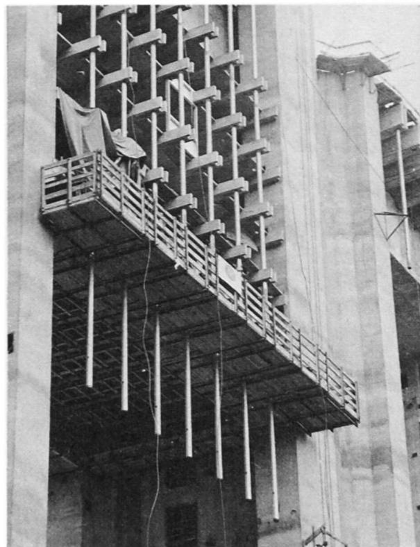
Schüßen montiert und an der Baustelle von der unter der Absenkschalung hängenden Bühne aus verschweißt.
