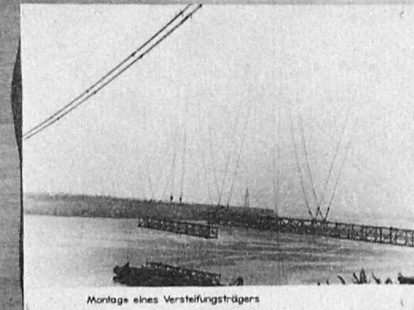
Montage eines Verstärkungsträgers
