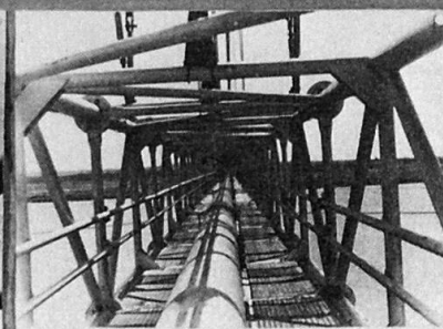
Konstruktion des Verstärkungsträgers, der die Rohrleitungsbrücke trägt
