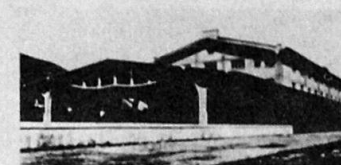
Lagerhaus mit Lagerhalle der SA Magazzini Generali in Chiasso, 1924 / 25
