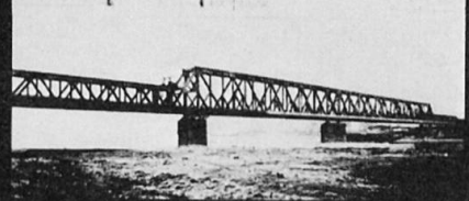
Die von Hartwich 1875 entworfene Rheinbrücke bei Düsseldorf-Rathausen war eine Eisenbrücke aus parallelen Dreifeldbrücken mit Kämpfergelenken und dreiteiligen Ständerfachwerk. Stützweite 58,08 m. Die Brücke wurde in den Jahren 1926 - 1927 durch einen Gitterträger als abgestuftes Parallelfachwerk unter Verwendung von St 48 ersetzt.
